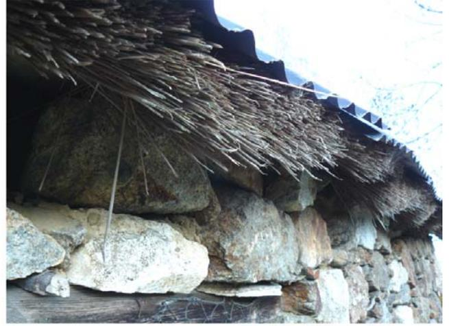
Toit de grange en chaume recouvert de tôle ondulée ("Cravet")
