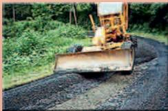
reçu cet été une couche de «grave émulsion» ; il s'agit d'une couche de préparation de la chaussée à froid (donc soucieuse de l'environnement) qui doit être compactée et se stabiliser durant quelques mois avant de recevoir une couche de finition (même si cela semble superflu au vu de l'aspect que présente la route après ce premier passage). Le revêtement définitif sera posé sur ces deux voies courant 2011 par les services du Conseil Général ■
