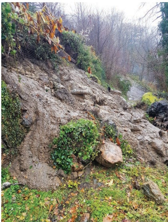
Au Souleillan, glissement de terrain début décembre 2021 et débordement d'un fossé
