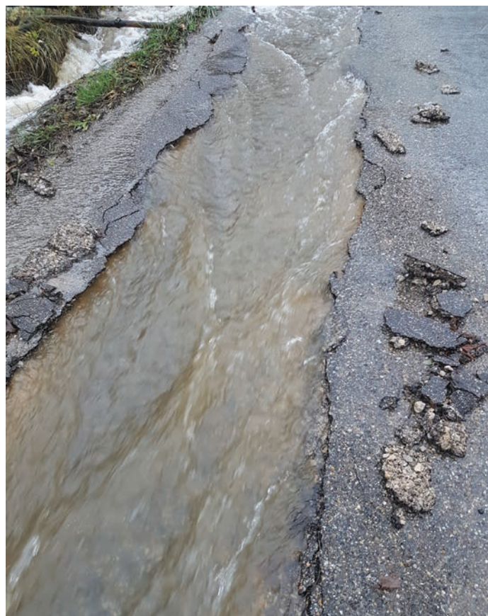
Angrillou : l'eau emporte la chaussée début décembre 2021
