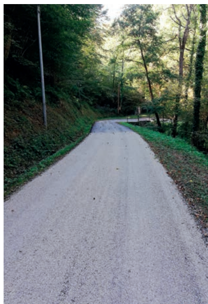
Route vers Bernicaou, alternance de revêtement enrobé et tricouches
