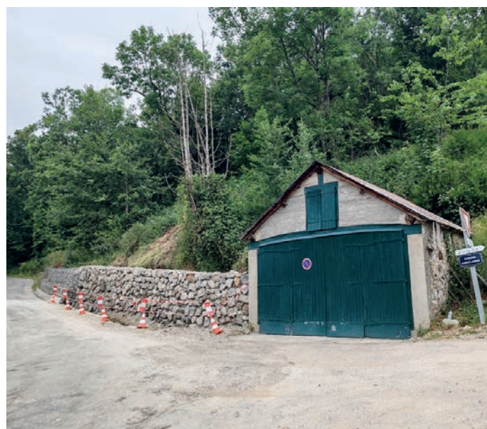
Mur en construction à Usclades
