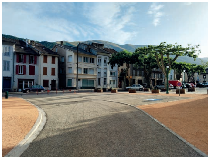
La nouvelle rue de l'Église
